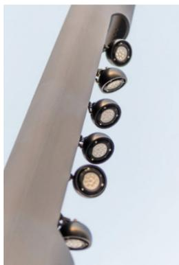
Die Masten sind mit Lichtpunktabständen von 18 bis 40m und einer Lichtpunkthöhe von 6,5 bzw. 8,5m jeweils den Treppenanlagen zugeordnet und stehen schräg um rund 15° zu ihnen geneigt.
