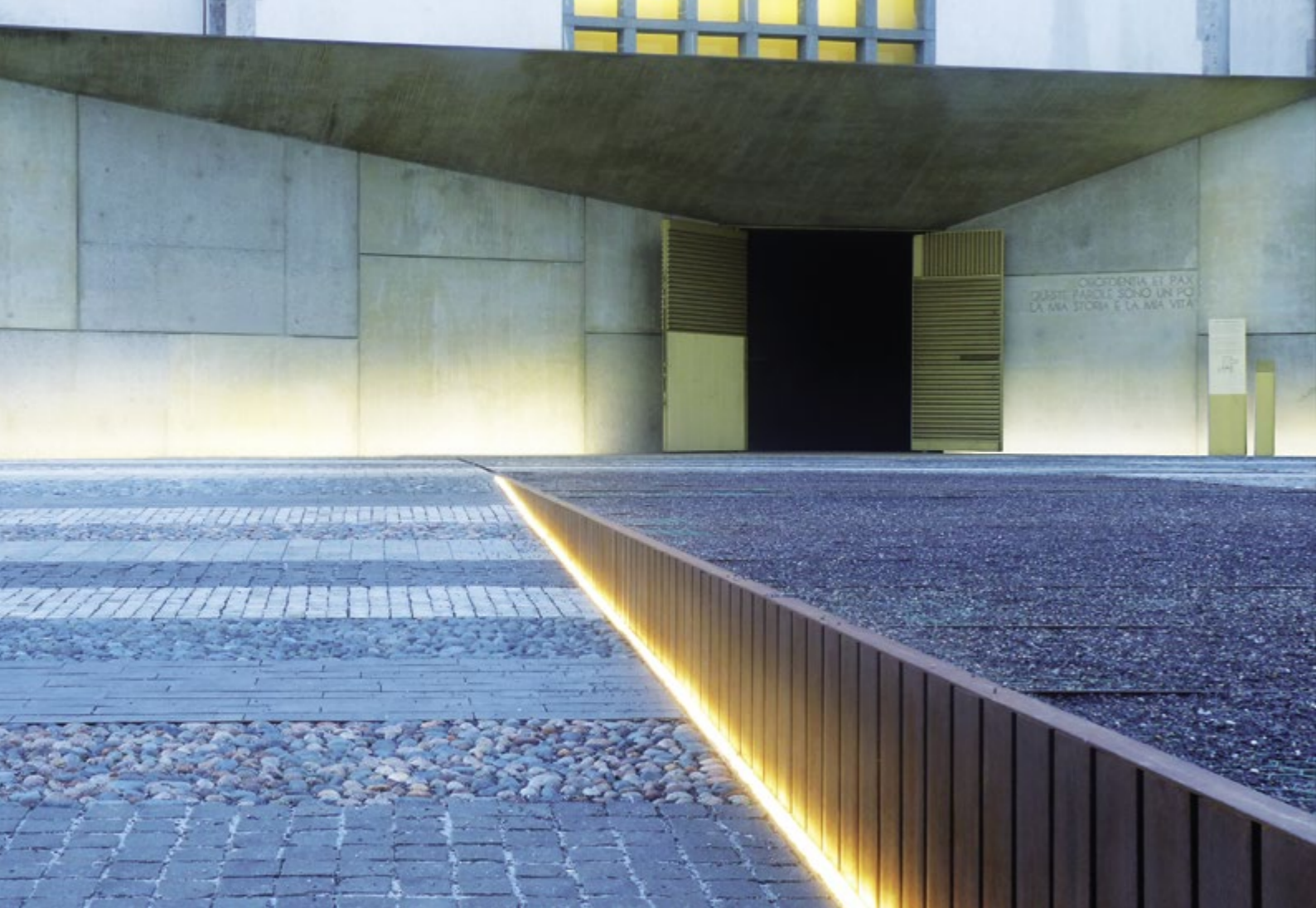
Giardino della Pace, Sotto il Monte, Bergamo, Italy © SIMES S.p.A.
