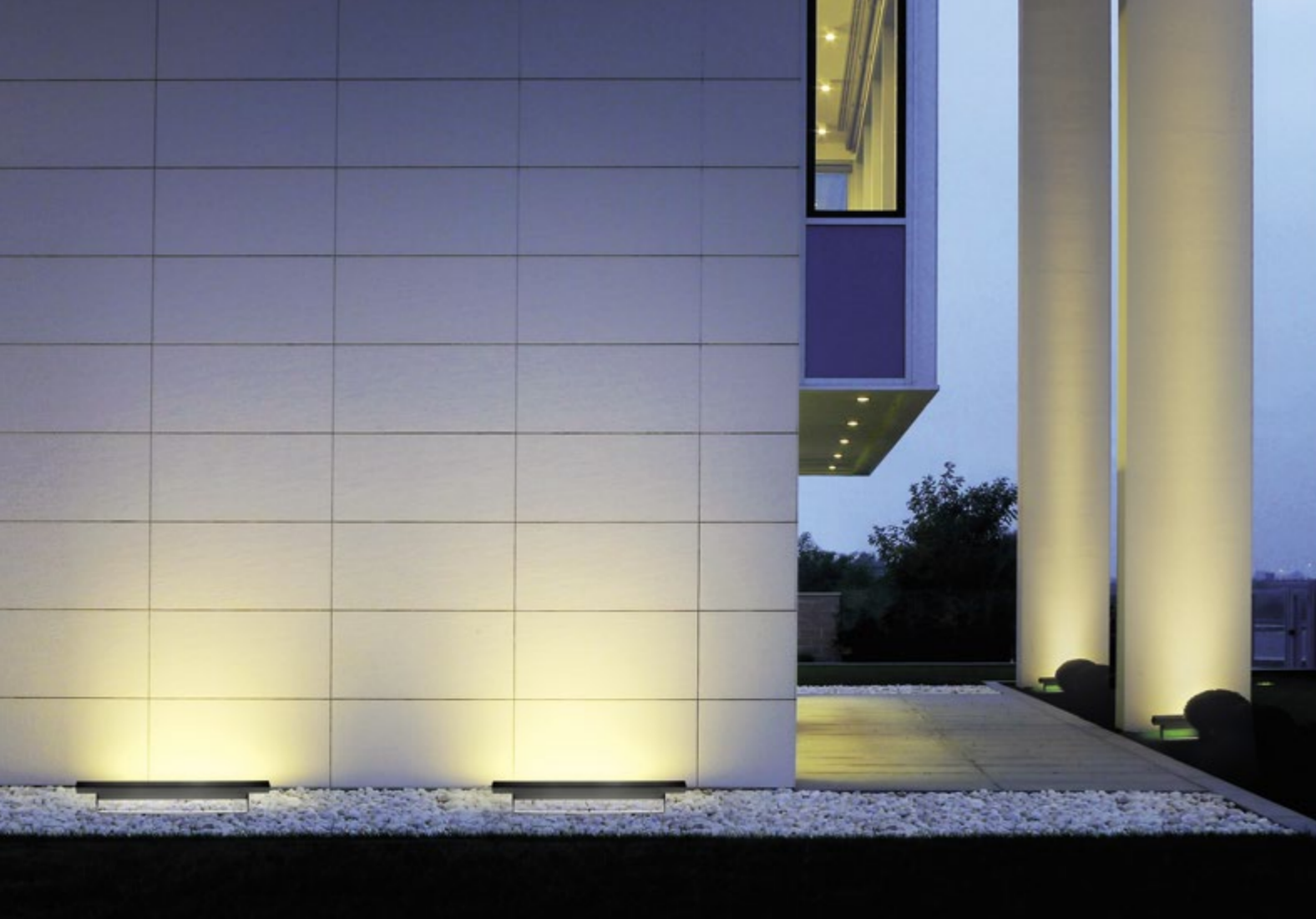
Ricca Costruzioni, Castrezzato (Brescia), Italy, Arch. Giovanni Mario Gozzini © SIMES S.p.a.
